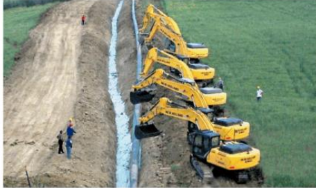
La realizzazione di un metanodotto
