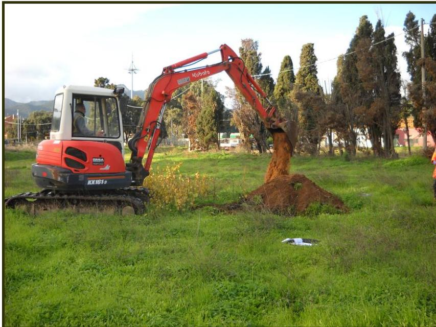
**Figura 18 – Escavatore meccanico cingolato di adeguata potenza.**
